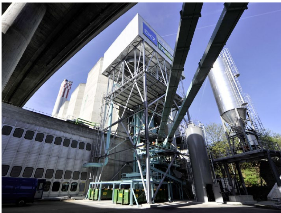
Die Beschickung der einzelnen Bunker erfolgt über reversierbare Förderbänder.
